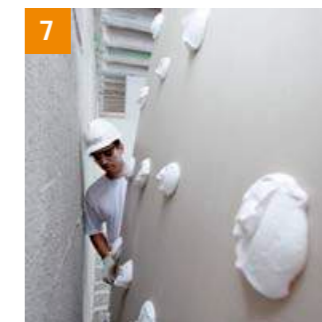
7 Chapa posicionada e pronta para a colagem
