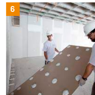
6 Apoio da chapa na base do piso
